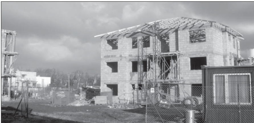
● Bytový dom pred zastrešením.
