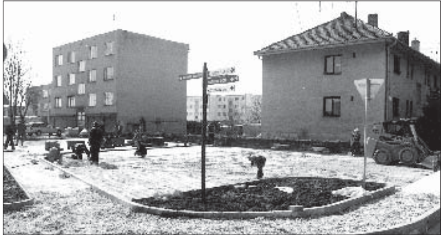
● Výstavba parkoviska na Ulici Petra Jilemnického.
