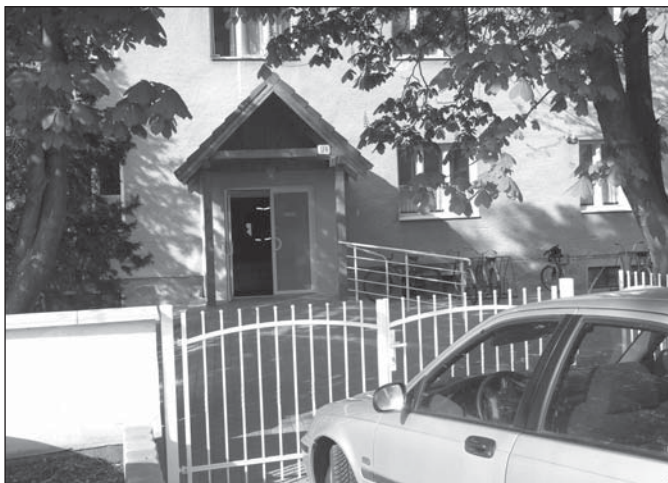
● V budove zdravotného strediska je už nová plynoinštalácia.
