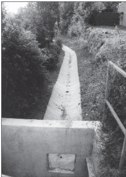
● Odvodňovací kanál z Trnavskej cesty.
