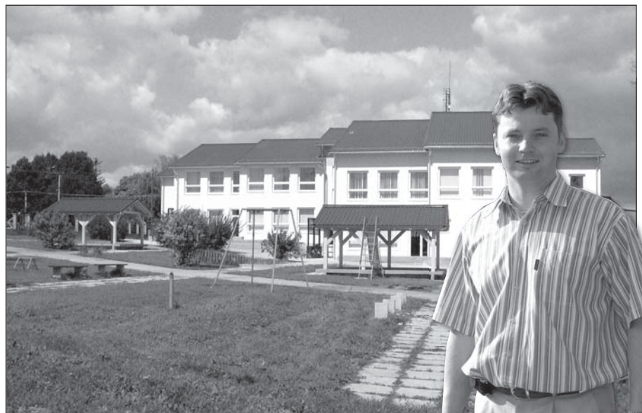
● Väčšina rekonštrukcie bola vykonaná za plnej prevádzky materskej školy.
