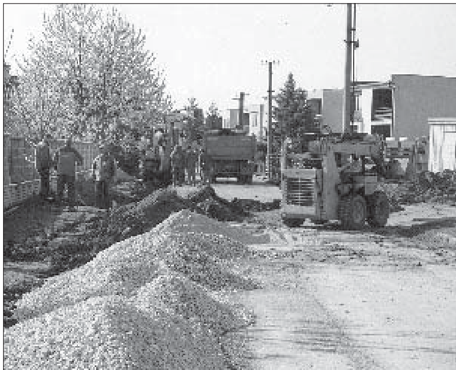
● Výstavba splaškovej kanalizácie na Ul. Petra Jilemnického.
