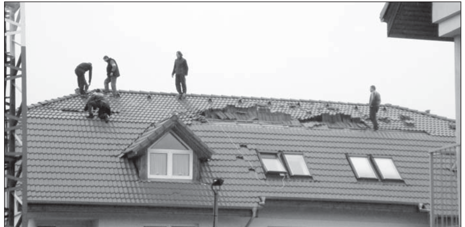
• Vďaka ochotným ľuďom, obe strechy boli v priebehu dvoch dní opravené.
