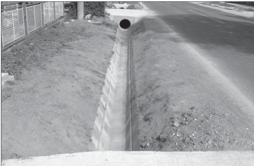
● Nové dažďové kanály na Trnavskej ceste.
