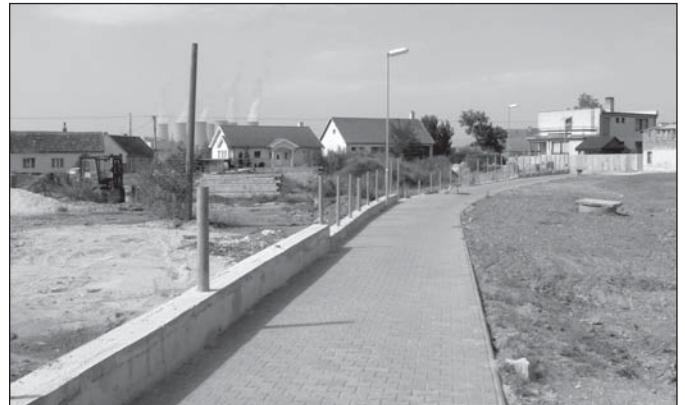
● Novovybudovaný chodník na Ul. M. Korvína.
