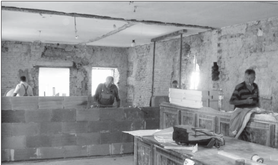
● Práce na prestavbe interiéru starej fary na dom opatrovateľskej služby.
