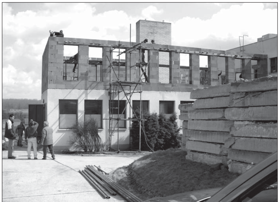
• Rovnú, už roky pretekajúcu strechu „zaizoluje“ nadväzba.
