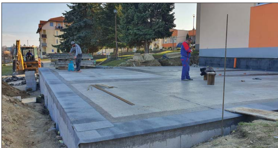
● Betónová platňa pripravená na výstavbu múrov
