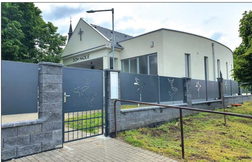
● Múr s kovovými prvkami a Dom nádeje pôsobia teraz ako celok
