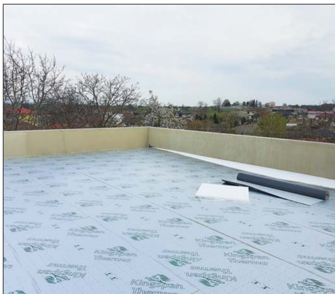
● Izolačné práce na budúcej terase s výhľadom na obec
