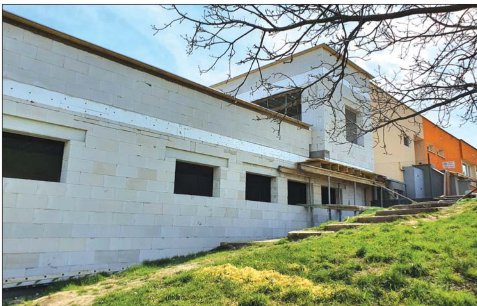
● Pohľad na zadnú časť komunitného centra
