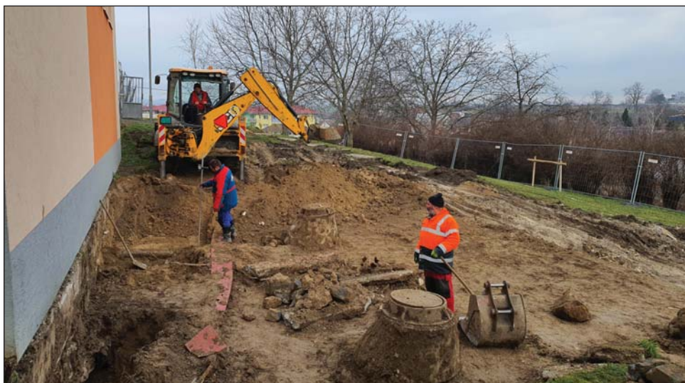
● Zemné práce na výstavbe komunitného centra
