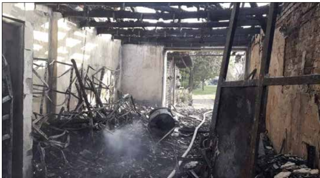
● Hasenie požiaru rodinného domu v obci Jaslovské Bohunice
