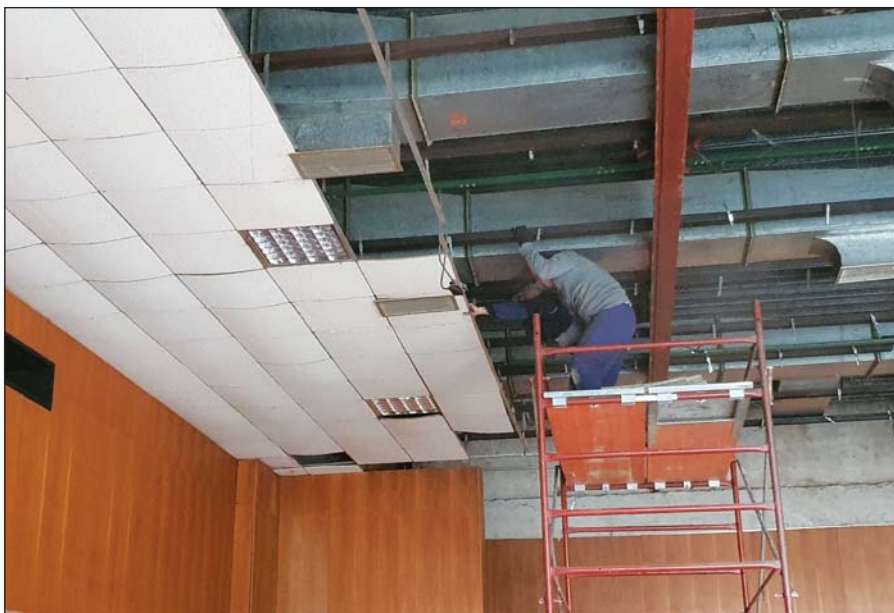
● Demontáž 38-ročných stropných kaziet
