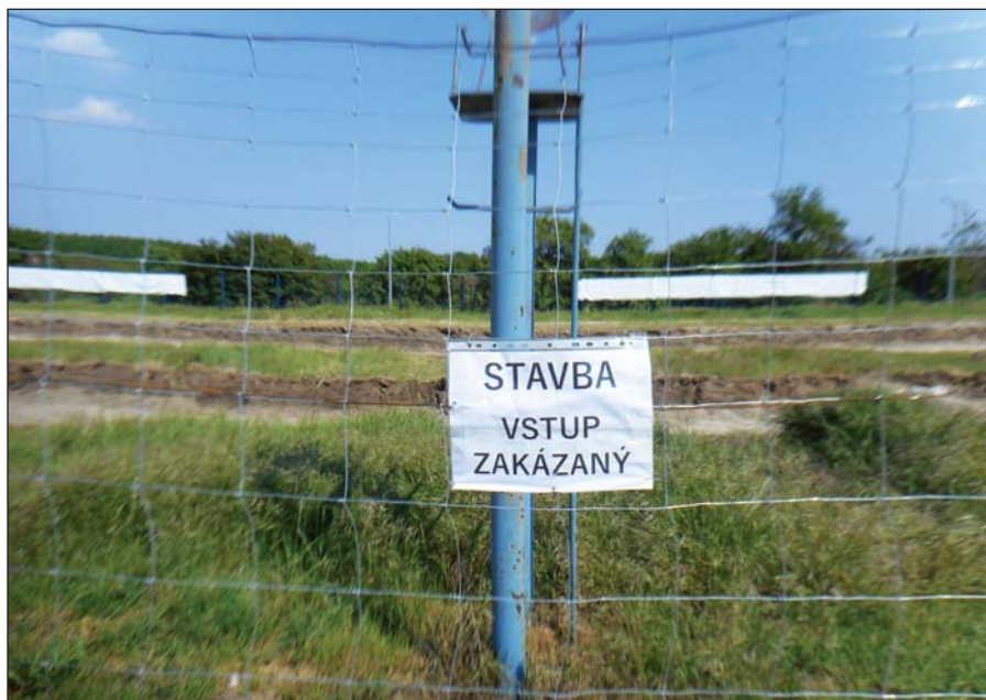
• Ohraničenie nového staveniska
