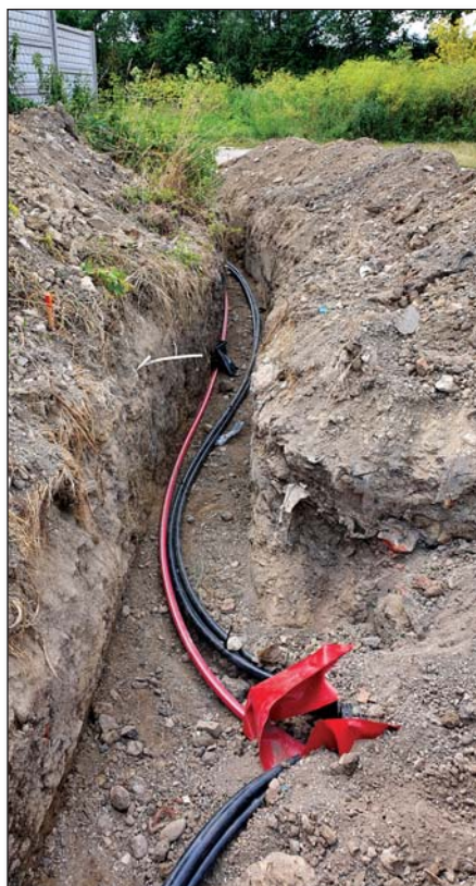
● Položené elektrické vedenie na Záhumenskej ulici spojí Piešťanskú cestu s Družstevnou ulicou
