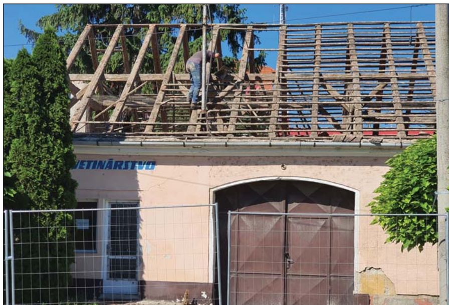
● Asanácia budovy sa začala rozbieraním krovu
