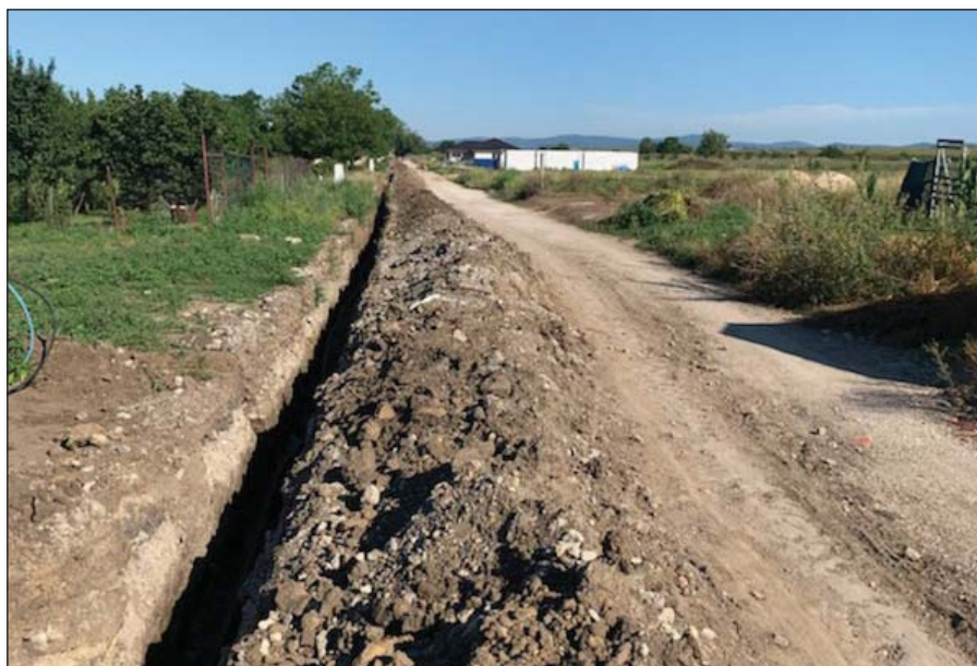
● Kladenie elektrických káblov na Záhumenskej ulici
