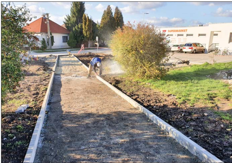
● Stavebné práce na chodníku na Ulici Ľ. Štúra pri supermarkete
