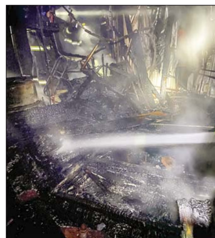
● Zásah hasičov pri požiari prístavby domu na Sadovej ulici
