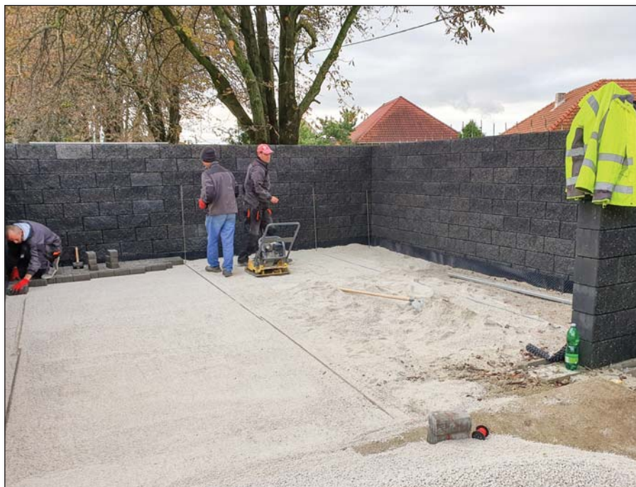
● V rámci výstavby nového oplotenia sa vybudovalo nové stojisko pre kontajnery s odpadom
