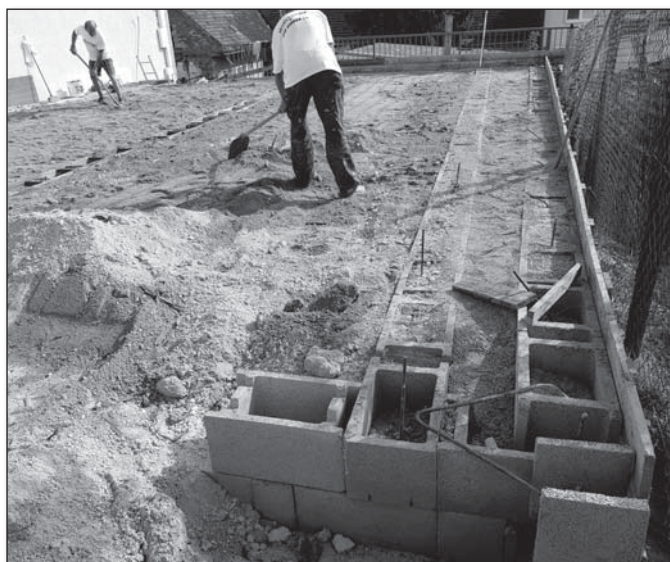
● Práce pred betónovaním základovej dosky garáže
