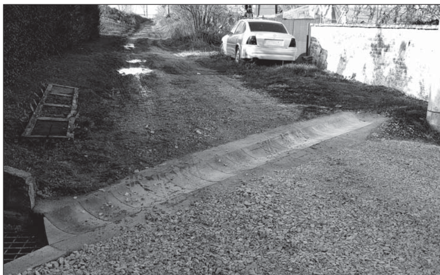
• Súčasťou rekonštrukcie na Trnavskej ceste bol aj nový žľab, ktorý zachytáva vodu z poľa, a vyštrkovanie poľnej cesty
