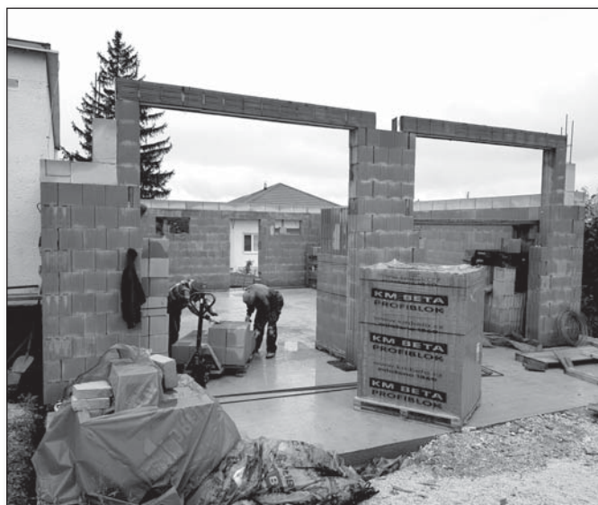
● Práce na murovaní garáže
