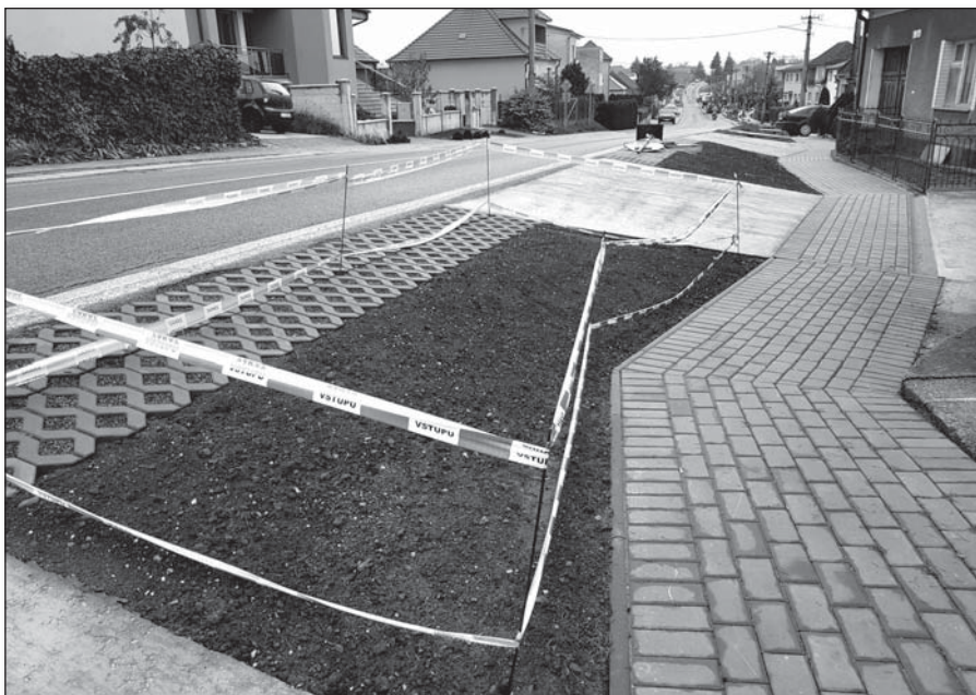
● Zrekonštruovaný chodník na Trnavskej ceste
