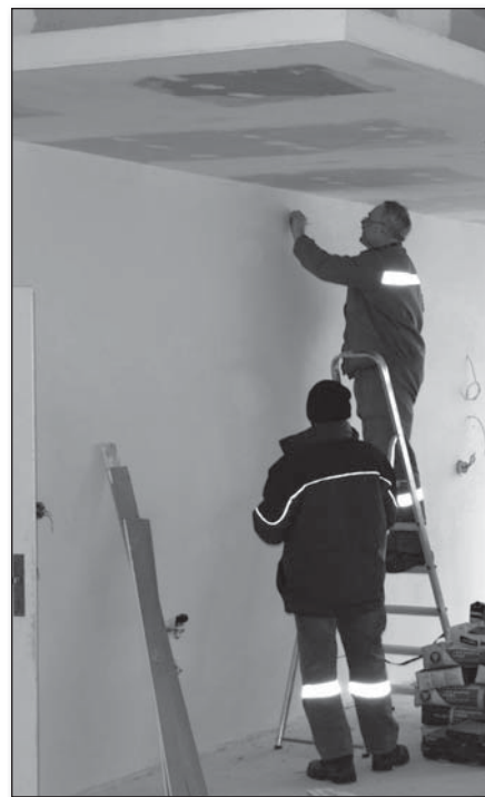
• Elektrikárske práce vykonávali na novom foyeri Ján Mečír a Pavol Košlab
