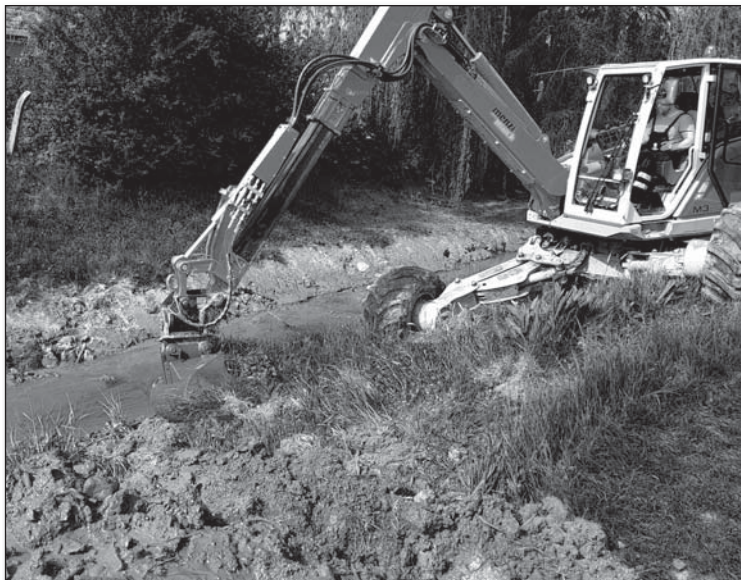
● Stroj Povodia Váhu Piešťany čistí koryto Chtelničky od nánosov zeminy
