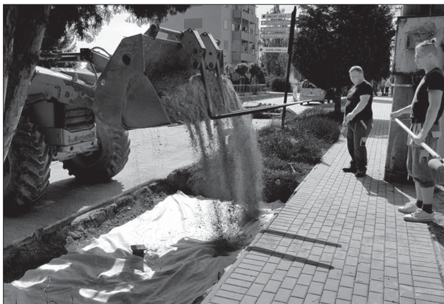
● Násyp štrku na lôžko pod nový vjazd
