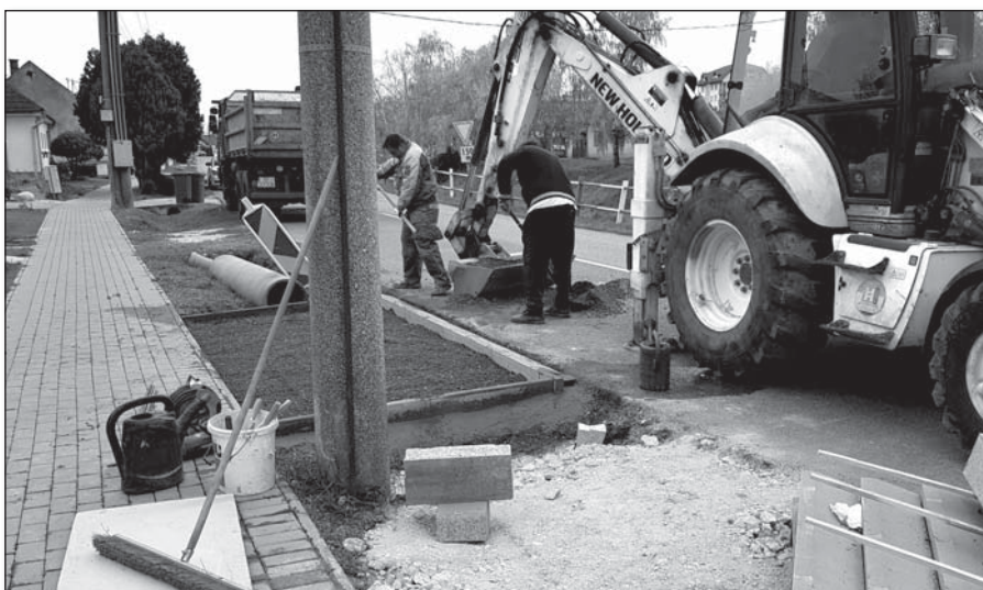
• Výstavba vjazdov na Družstevnej ulici je ukončená
