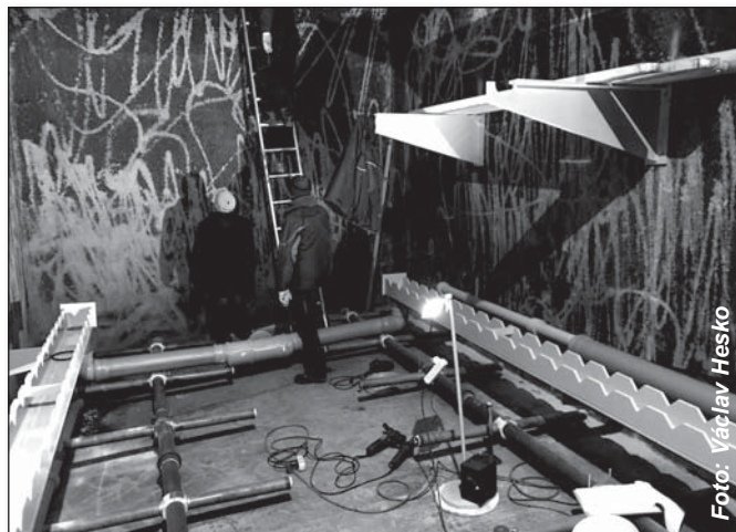
• Montáž odtokových žľabov a napúšťacích potrubí
