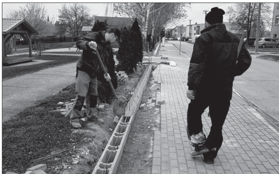
• Stavební robotníci pracujú na rekonštrukcii stavebnej časti oplatenia materskej školy Foto: Gilbert Liška
