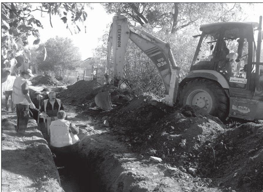
● Stavebným robotníkom ako aj celej stavbe októbrové počasie prišlo
