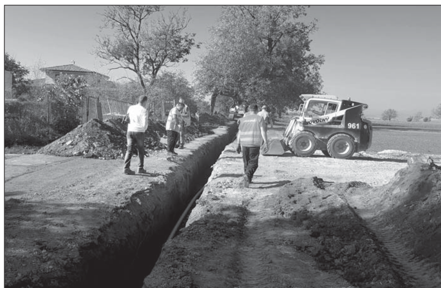
● Pracovní ruch na Záhumenskej ulici je predpokladom, že základné inžinierske siete budú už onedlho slúžiť novým občanom ulice
