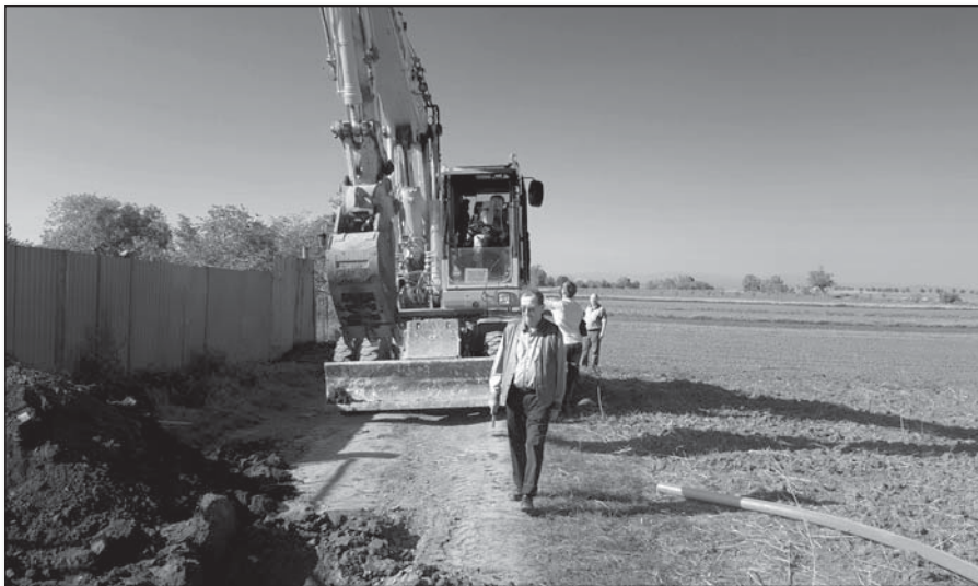
● Stavebný dozor (v popredí) kontroluje uloženie potrubia vo výkope
