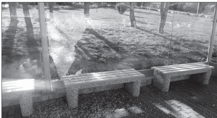
● Novú čakáreň vandali poškodili dva mesiace po jej osadení
