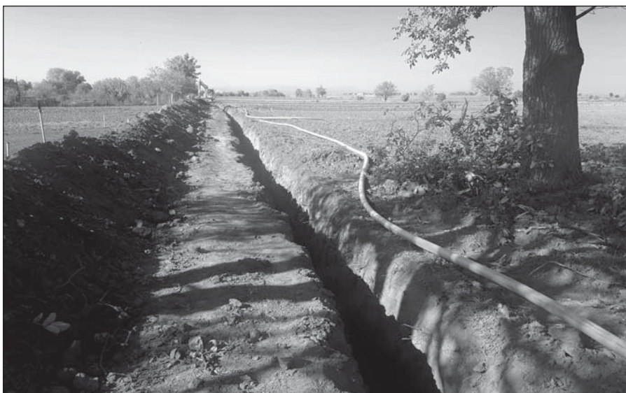
● Potrubie na plyn čaká na uloženie do výkopu
