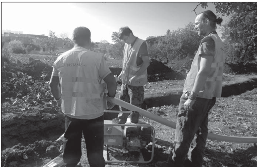
● Zváranie plynového potrubia
