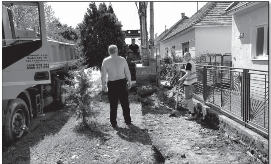
● Výstavba chodníka na Ulici Ľ. Štúra
