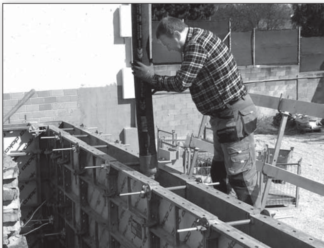
● Betónovanie oporného múra pri hasičskej zbrojnici Foto: Gilbert Liška
