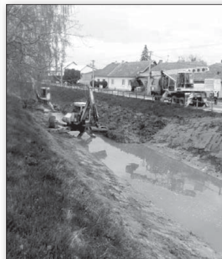
● Čistenie potoka na Družstevnej ulici
