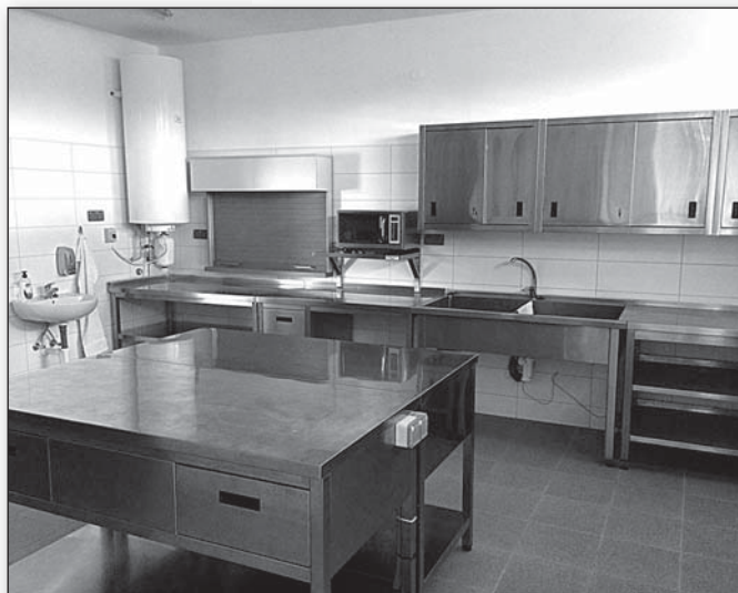
● Pohľad do zrekonštruovanej kuchyne
