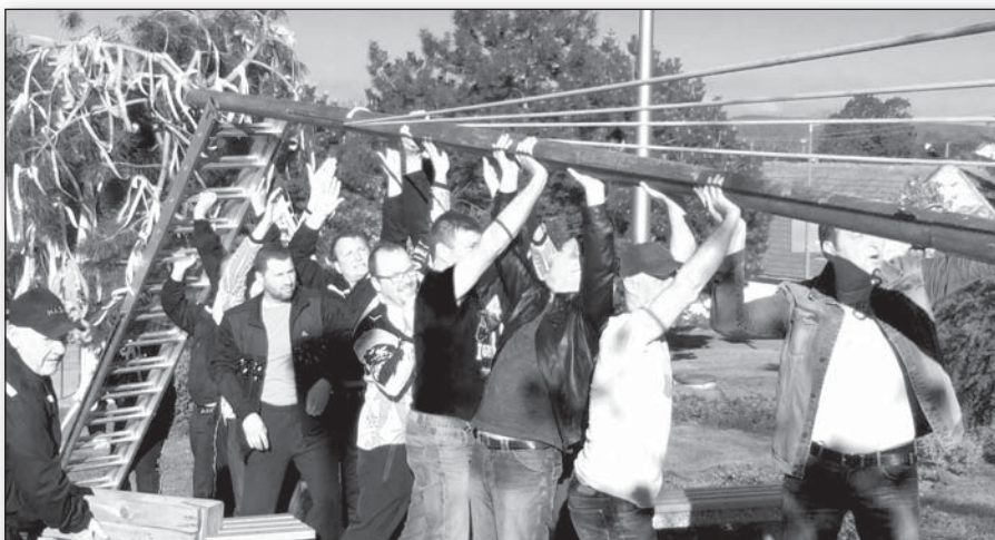
• Dvíhanie mája, ktorý má kovovú konštrukciu, bolo náročné, ale chlapi to zvládli
