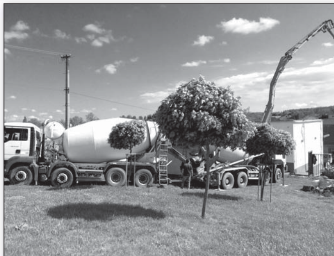
● Betónovanie oporného múra bolo komplikované z dôvodu zlej dostupnosti stavby Foto: Gilbert Liška
