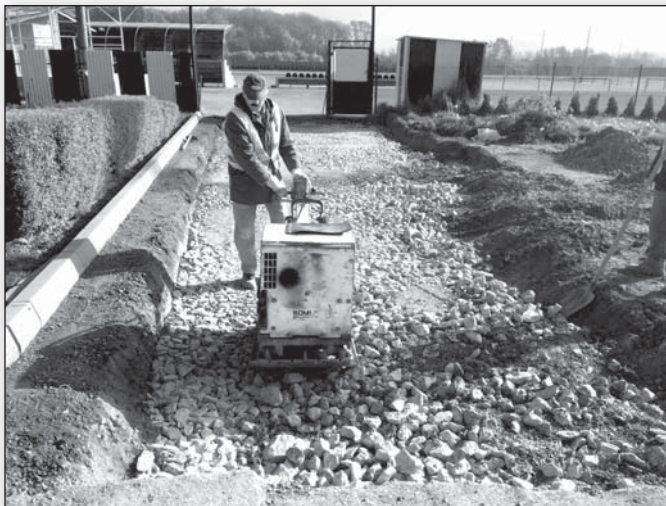
● Rekonštrukcia časti Športovej ulice – zhutňovanie lôžka
