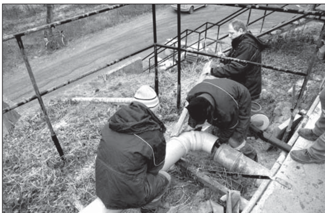
● Osádzanie kanalizačných rúr
