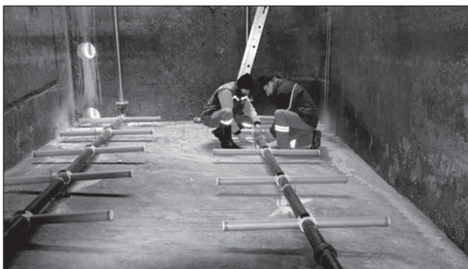
● Pracovníci Katelstavu Vladimír Mišík a Jozef ..... pri montáži prevzdušňovacieho systému v nádrži čistiarnie odpadových vôd
