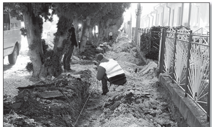
● Meranie výšok budúceho chodníka je dôležitý krok
