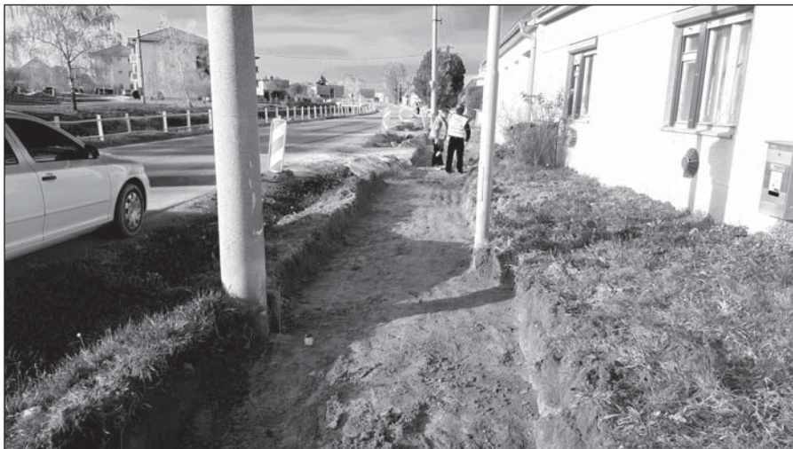
● Vybraté podložie pred výstavbou chodníka na Družstevnej ulici
