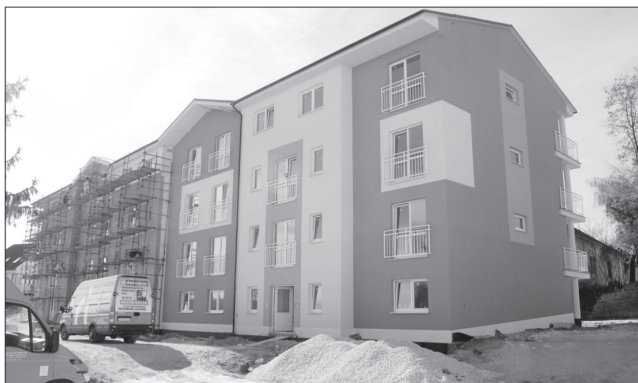
● Práce na vnútorných úpravách bytového domu sa blížia do finále.
