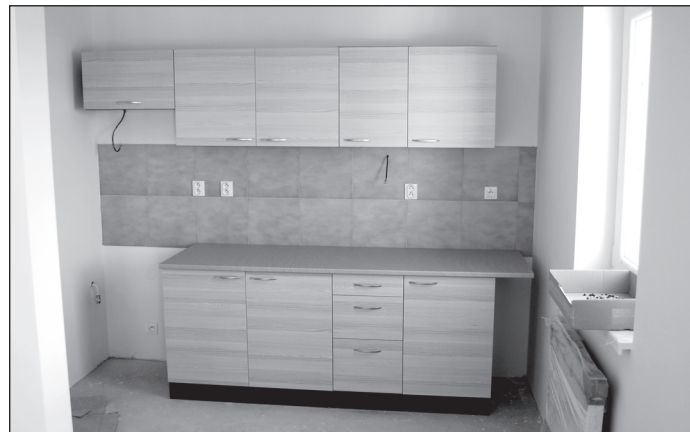
● V súčasnosti stavitelia realizujú montážne práce kuchynských liniek a sprchovacích kútov.
