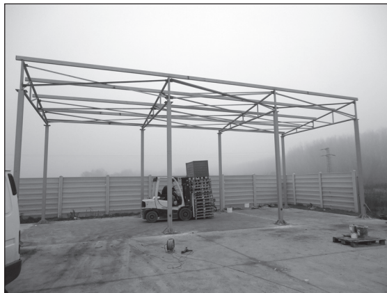
• Výstavba nového prístrešku na zbernom dvore.
