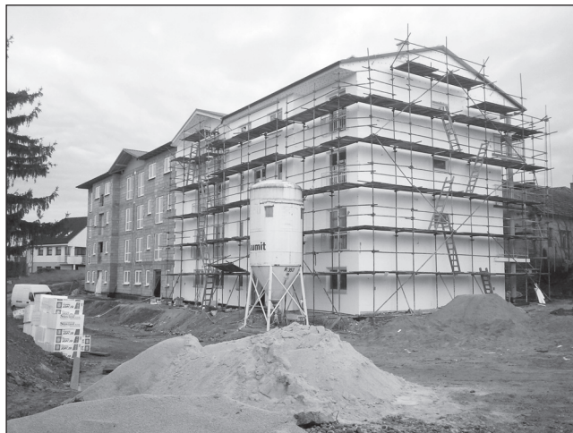
● Zatepl'ovanie 28-bytového domu, ktorého výstavba bola zrealizovaná v tomto roku.
