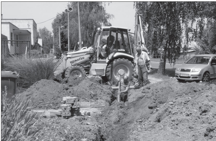
• Výstavba kanalizačných prípojek na Ulici C. Majerníka.
