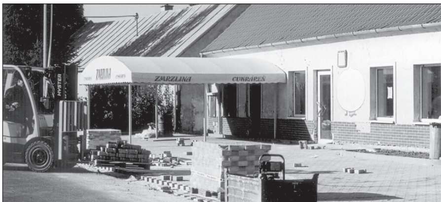
● Rok 2007 – Výstavba spevnených plôch na Ul. J. Hollého.
