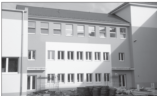
● 2010 – Pohľad na nadstavbu budovy, v ktorej sa budú nachádzať dve špecializované učebne a kabinet.
