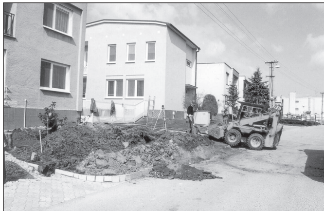
● 2007 – Výstavba domových kanalizačných prípojok na Ul. P. Jilemnického.
