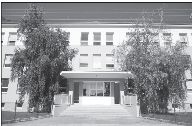
● 2010 – Zrekonštruovaná základná škola.
