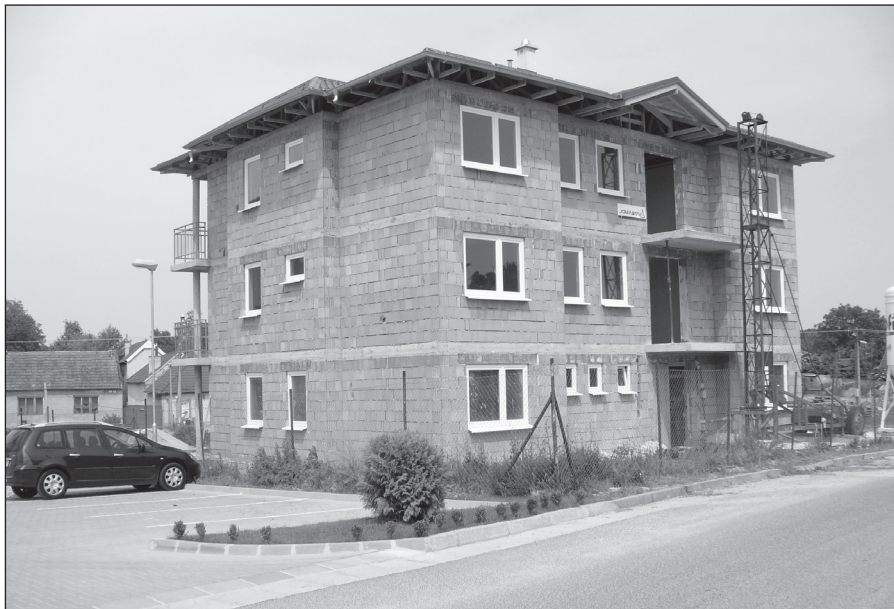
● Roky 2009 – 2010 – Výstavba 6-bytového domu na Mierovej ulici.
