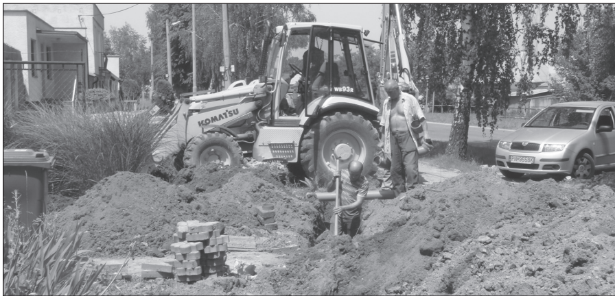
● Rok 2009 – Výstavba kanalizačných prípojek na Ulici C. Majerníka.
