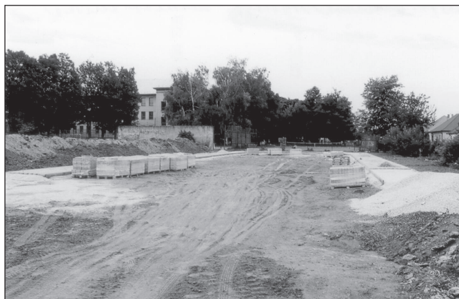
● 2007 – Začiatok výstavby detského ihriska.
