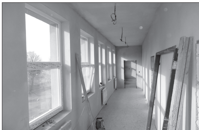
● 2010 – Chodba v novej nadstavbe základnej školy.
