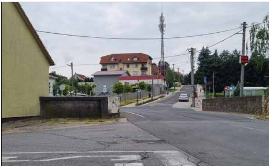
• Zľava nie je vidieť prichádzajúce vozidlo kvôli neprehľadným stenám mostnej konštrukcie
