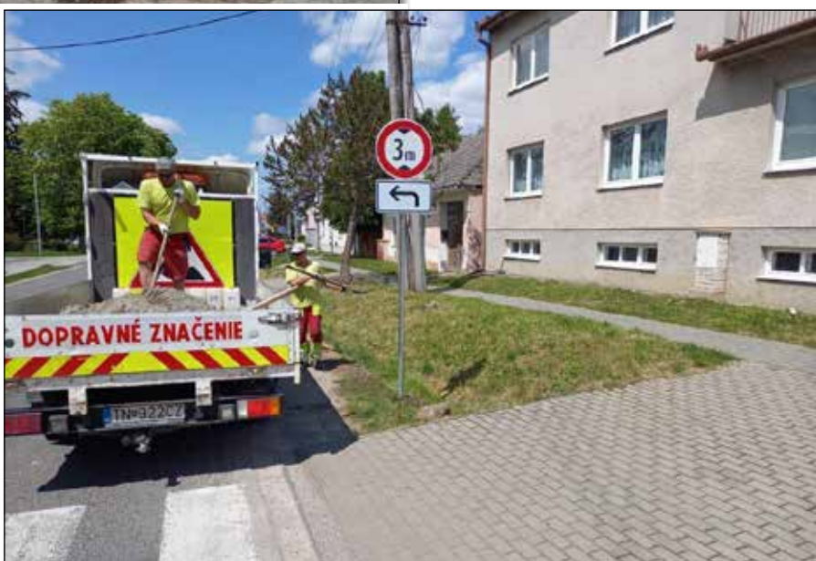
● Pracovníci osádzajú nové dopravné značenie
