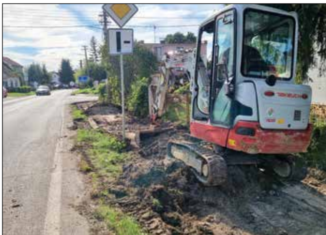
• Odstraňovanie pôvodnej dlažby chodníka na Piešťanskej ulici
