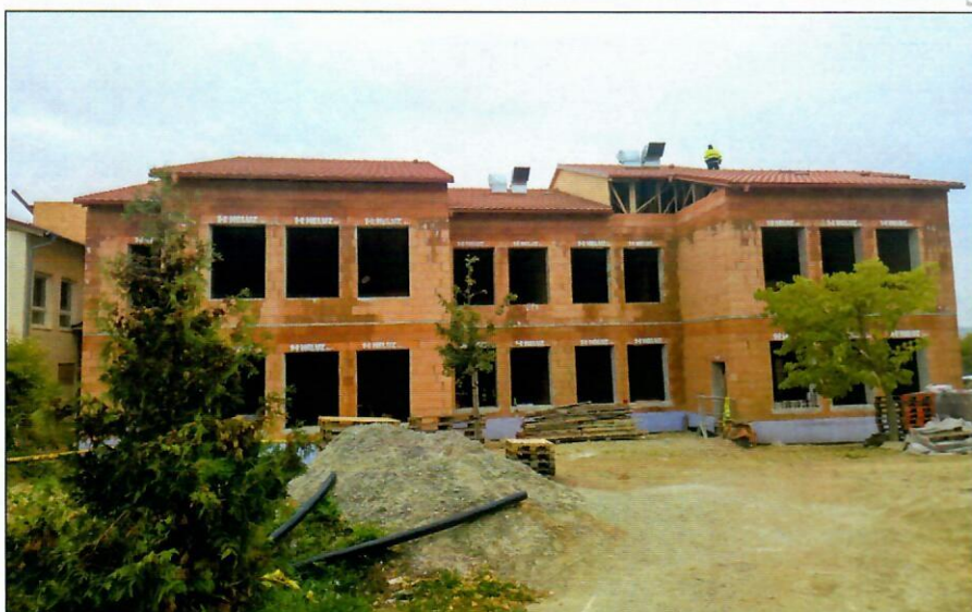
● Hrubá stavba novej materskej školy je už hotová
